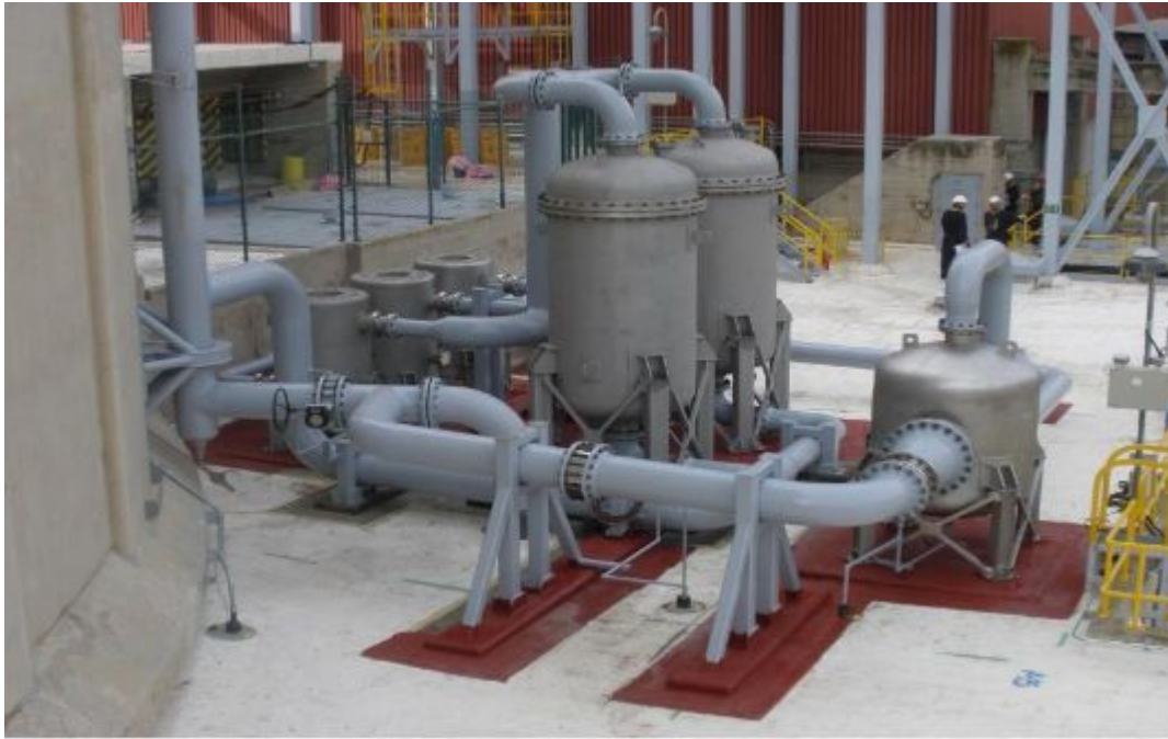
Implantación de un Sistema de venteo filtrado en la central nuclear de Cofrentes, Valencia, circa 2020 (1984-activa)
