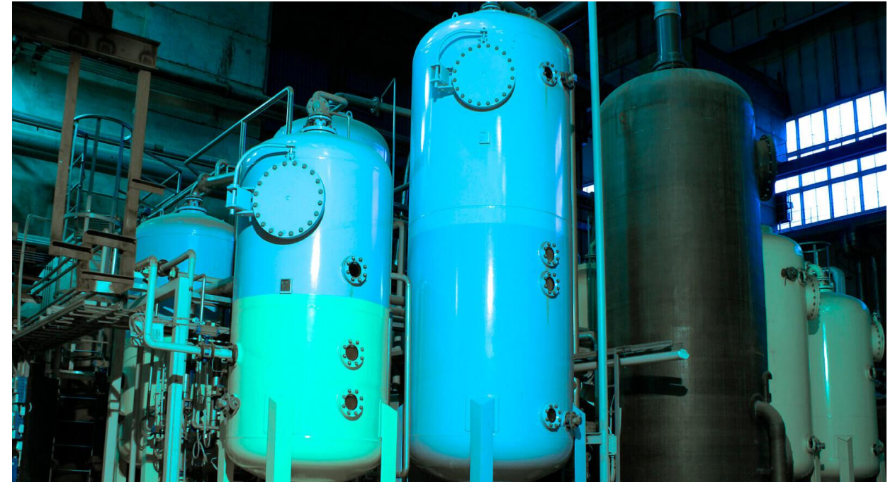
Implantación de un Sistema de venteo filtrado en la central nuclear de Ascó, Cataluña, circa 2020 (1984-activa)
