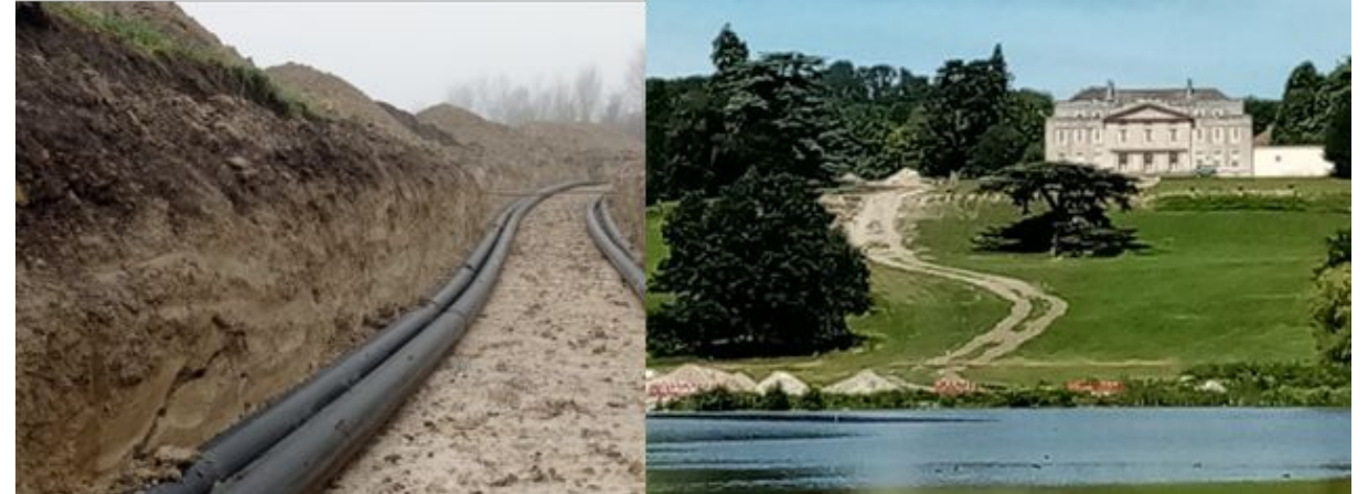
SISTEMA DE CAPTACIÓN
